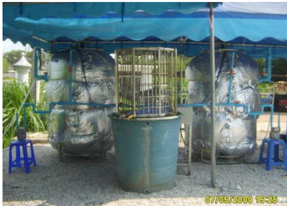
รูปที่ 3 ระบบบ่อหมักของแฉังแบบไร้ออกซิเจนชนิดถึงกวนต่อเนื่อง
