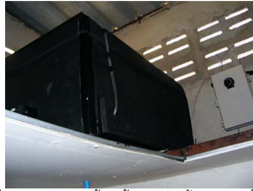
รูปที่ 1 แสดงการติดตั้งถึงน้ำอุ่นเหนือฝ้าห้องอาบน้ำ
