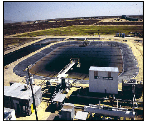
รูปที่ 2 บ่อความร้อนพลังงานแสงอาทิตย์ที่ EL Paso USA (Jimmy Leblanc: 2010)
