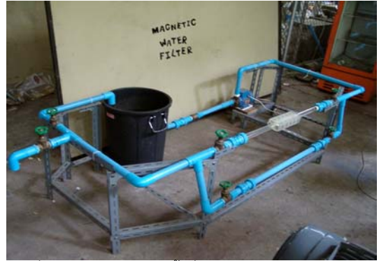
รูปที่ 1 แสดงระบบบำบัดน้ำที่ใช้ในการทดลอง
