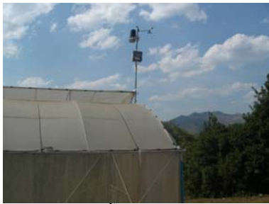
รูปที่ 6 แสดงการติดตั้งอุปกรณ์วัดอุณหภูมิภายนอก
