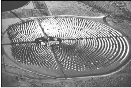
รูปที่ 1.1 ระบบรวมแสงอาทิตย์ของโครงการ Solar one
