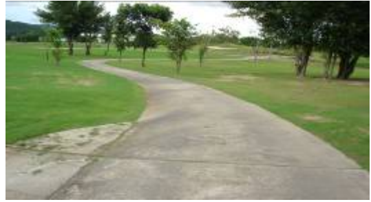
รูปที่ 10 ลักษณะของถนนคอนกรีตไม่ได้ลาดยาง
