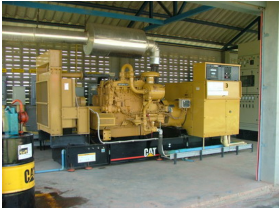
รูปที่ 1 เครื่องปั่นไฟแบบที่ใช้ Generator ขนาด 250 kW
