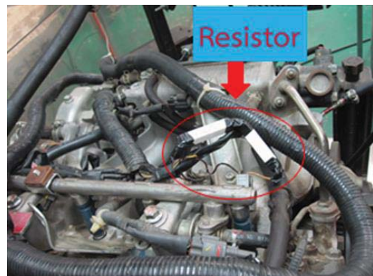
รูปที่ 1 ตำแหน่งการติดตั้งตัวต้านทานขนาด 10 และ 20 โอห์มเพื่อการจำลองความผิดปกติที่หัวฉีดสูบที่ 4
