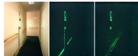
รูปที่ 3 แสดงไฟนำทางบริเวณทางเดิน [4]
